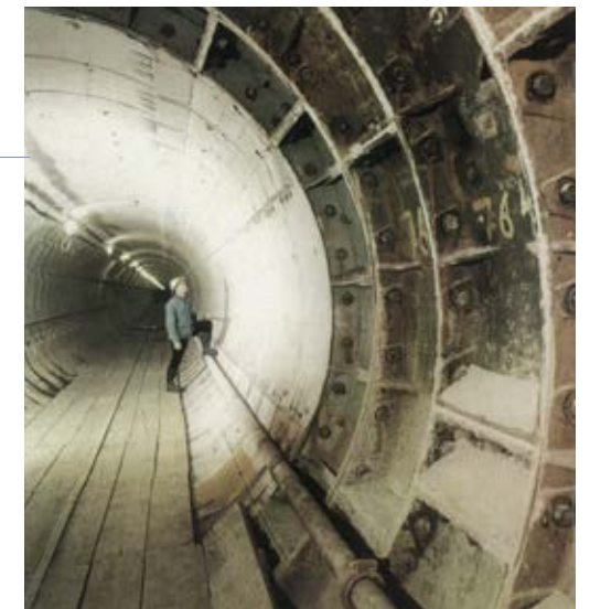
Der erste Rheindüker bei Düsseldorf: Das fortschrittliche Projekt wurde Ende der 1950er-Jahre unter dem Namen Poseidon realisiert.
